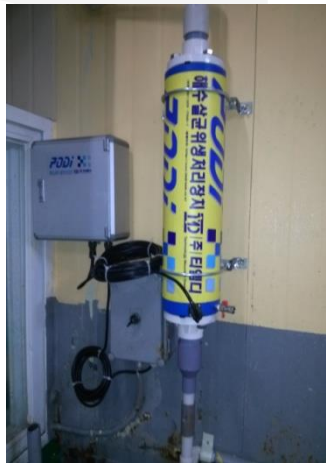
기계 설치 사진
